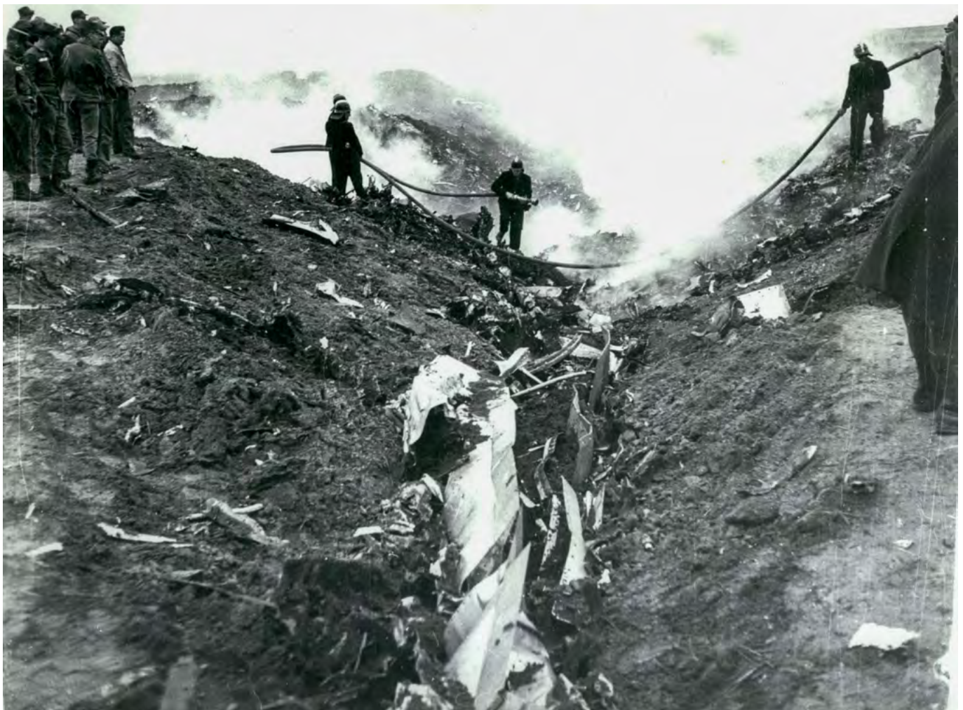
Feuerwehrlaute bei Löscharbeiten am 12. Dezember 1961. In dem tiefen Loch sind nach dem Aufprall nur noch kleine Teile des riesigen Düsenflugzeugs zu finden. Bild: IMAGO/ZUMA/Keystone (imago 0061861274)
